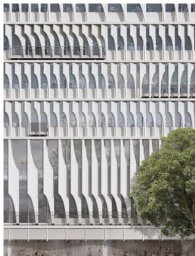
Siegerprojekt «Gloria», Visualisierung der Fassade: Die Form der Lamellen soll im unteren Teil den Blick nach aussen ermöglichen, im oberen vor der Sonneneinstrahlung schützen.
